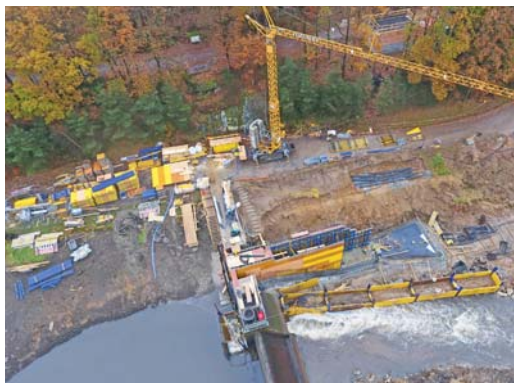
Die Vorsperre wurde über den bestehenden Grundablass komplett geleert und daraufhin konnte mit dem Eingriff an der Beton-Vorsperre begonnen werden. Für die Auflagerung der Hubzylinder wurde durch den Planer (Lahmeyer Hydroprojekt GmbH) gemeinsam mit der HSI Hydro Engineering GmbH ein neues Konzept entwickelt.
