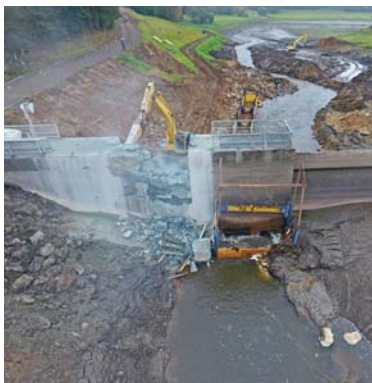
Die Vorsperre wurde über den bestehenden Grundablass komplett geleert und daraufhin konnte mit dem Eingriff an der Beton-Vorsperre begonnen werden. Für die Auflagerung der Hubzylinder wurde durch den Planer (Lahmeyer Hydroprojekt GmbH) gemeinsam mit der HSI Hydro Engineering GmbH ein neues Konzept entwickelt.
