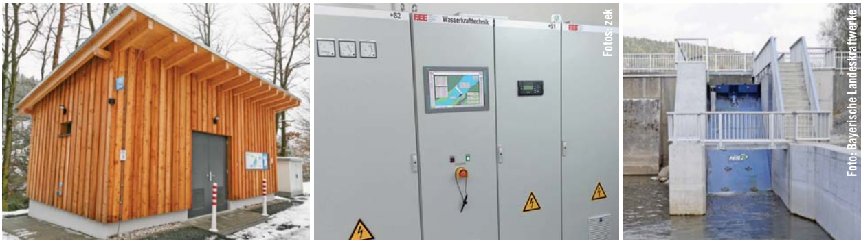
Das Betriebsgebäude inklusive Steuerungseinheit von F.EE wurde unweit dem Betonwehr auf hochwassersicherem Terrain errichtet. Mit Eixendorf II konnte eine optimale Lösung für diesen Standort gefunden und umgesetzt werden. Das ökologische Wasserkraftwerk nahm fünf Jahre nach Projektbeginn den Betrieb auf.
