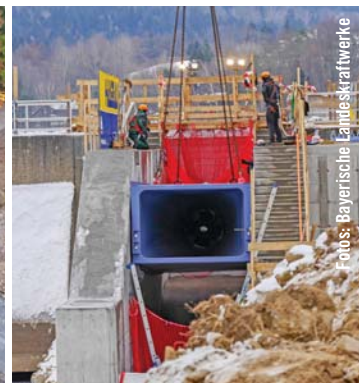
Die Vorsperre wurde über den bestehenden Grundablass komplett geleert und daraufhin konnte mit dem Eingriff an der Beton-Vorsperre begonnen werden. Für die Auflagerung der Hubzylinder wurde durch den Planer (Lahmeyer Hydroprojekt GmbH) gemeinsam mit der HSI Hydro Engineering GmbH ein neues Konzept entwickelt.
